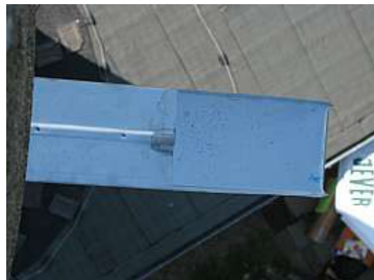
Wasserführung mit Kupferblech (Speyer)
