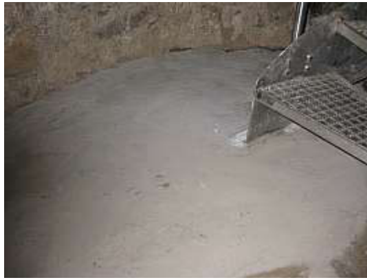
Nach Versiegelung der Aussichtsplattform wurde auch die Plattform am Fuße der Edelstahlterasse versiegelt.
