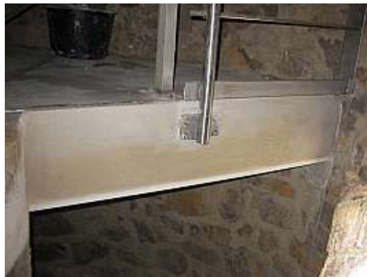
Ersatz und Reparatur
