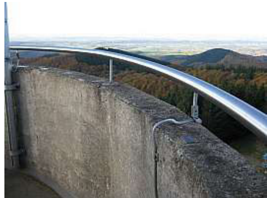
Neuer Mauerhandlauf aus Edelstahl
