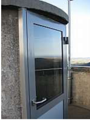
Neue Aluminiumtür mit großem Fenster, um genug Licht für den Aufstieg zu haben
