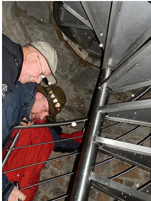
Neue Wendeltreppe aus Edelstahl
